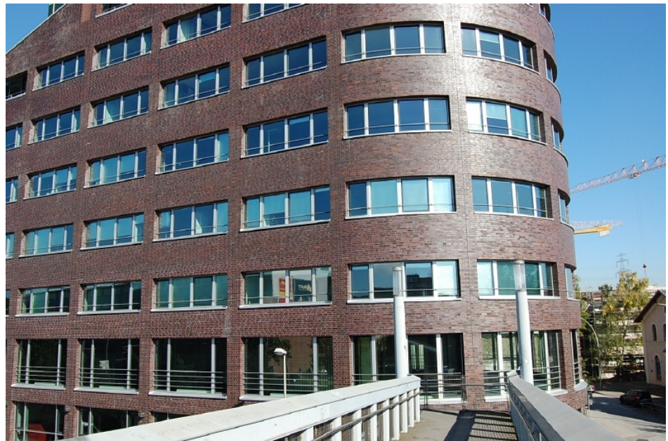
Ansicht von der Brücke
