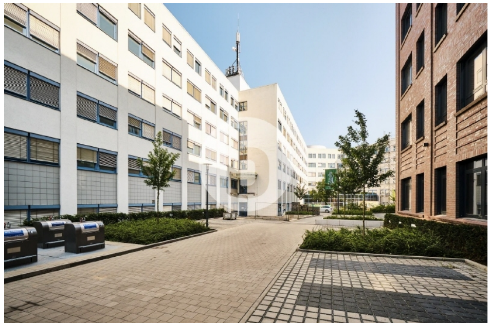
Marzipanfabrik Haus 19 Außenansicht
