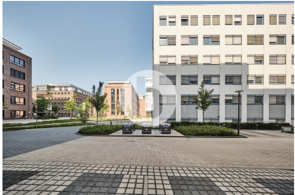
Marzipanfabrik Haus 19 Außenansicht
